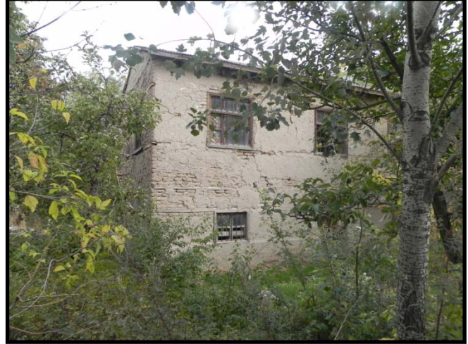
Fotoğraf/Picture 35 – Kerpiç Yapının Ön Cephesi 2 / Front View of the Mud-Brick Masonry Building 2
