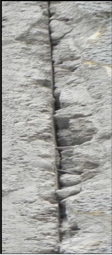
Fotoğraf/Picture 31 – Duvar Malzemesi ve Örgü Tekniği (Beton Blok ve Donatılı Duvar Örgüsü) / Wall Material and the Construction Method (Concrete Blocks and Reinforced Masonry Technique)
