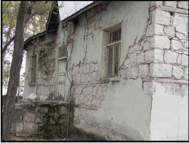
Fotoğraf/Picture 41 – Taş Yığma Binada Yatay Ahşap Kirişlemeler / The Horizontal Timber Ties within the Stone Masonry Walls
