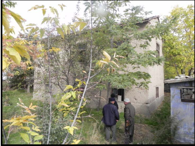
Fotoğraf/Picture 34 – Kerpiç Yapının Ön Cephesi 1 / Front View of the Mud-Brick Masonry Building 1
