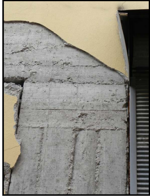
Fotoğraf/Picture 44 – 43 Numaralı Fotoğraftaki Binada Dış Kolon Kiriş Birleşimi / A Corner Beam Column Joint from the Building Shown in Picture 43
