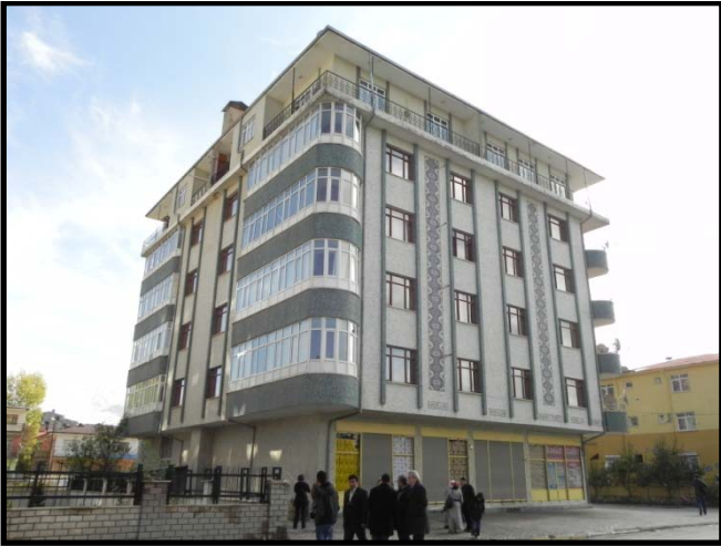
Fotoğraf/Picture 49 – Perde+Çerçeve Orta Hasarlı Bir Yapı / Frame+Structural Wall Building with Moderate Damage
