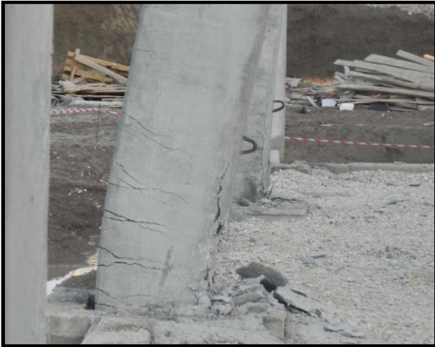
Fotoğraf/Picture 81- Kolon Alt Bölgesinde Plastik Mafsal / Plastic Hinging at Column Base
