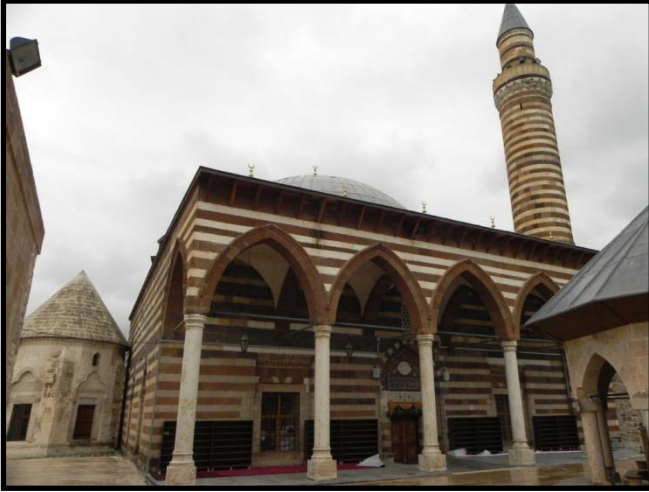
Fotoğraf/Picture 3- Hüsrev Paşa Camii Genel Görünüşü / General View of Husrev Pasha Mosque
