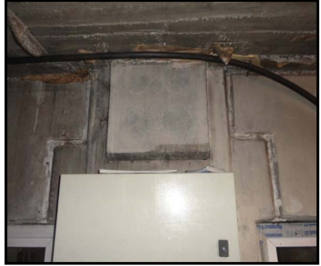
Fotoğraf/Picture 74 – Hasarsız, Ard-germeli Birleşim / The Damage Free, Post-Tensioned Connection
