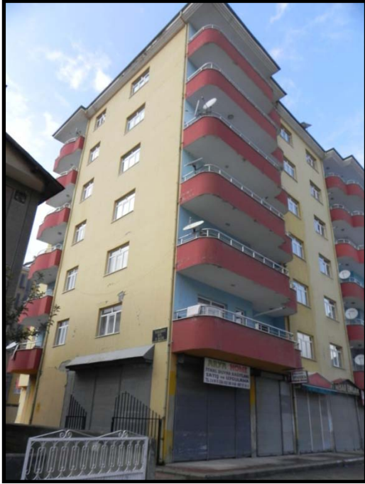
Fotoğraf/Picture 43 – Van İl Merkezinde Minimal Hasarlı Bir Yapı (yaklaşık c_x/c_y : 30x50cm; yaklaşık aks açıklığı 4.00 – 5.00m) / Building with Minor Damage at Van City Center (approximate c_x/c_y :30x50cm; approx. span lengths 4.00 to 5.00 m)
