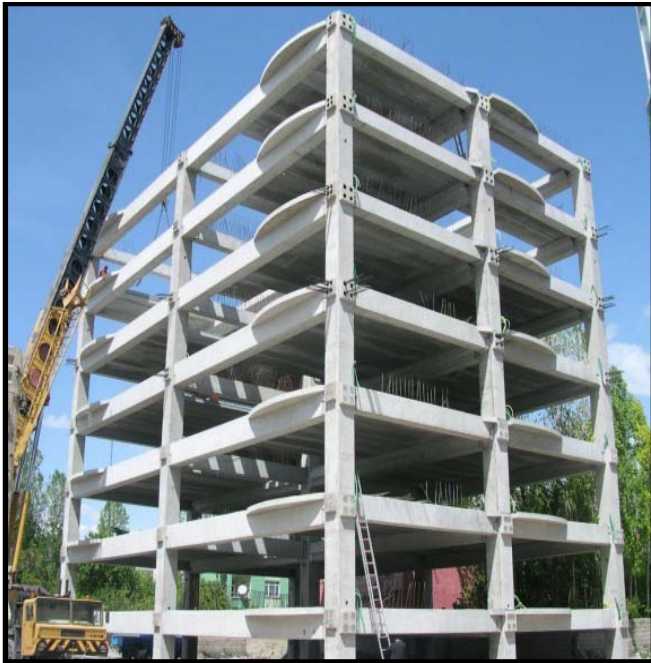
Fotoğraf/Picture 71 - Ard Germeli Birleşimlere Sahip Binanın İmalat Aşamasından Bir Görüntü / Moment Frame of the Building with Post-Tensioned Connections (from the time of construction)
