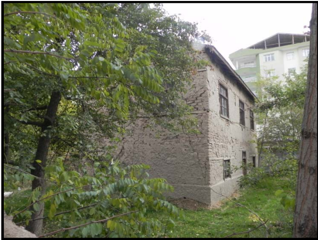
Fotoğraf/Picture 36 – Kerpiç Yapının Yan Cephesi ve Ahşap Kirişlemeler / Side View of the Mud-Brick Masonry Building and the Timber Ties in the Walls
