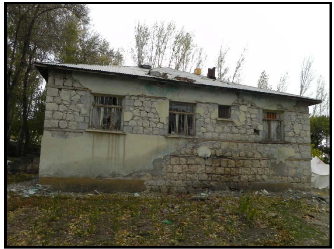
Fotoğraf/Picture 40 – Taş Yığma Bina Yan Cephe Genel Görünüş / General View of The Stone Masonry Building, Side Face
