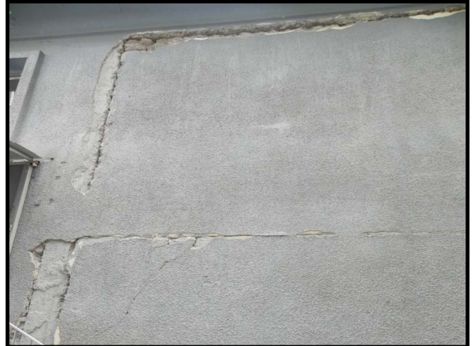
Fotoğraf/Picture 33 – Binanın yan Duvarları / Side Walls of the Building
