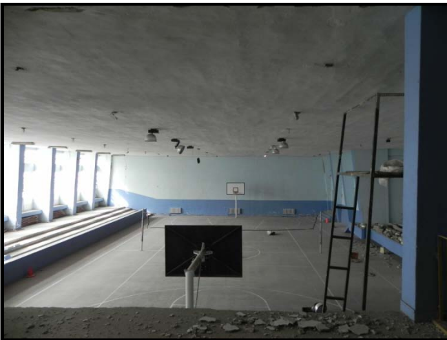
Fotoğraf/Picture 68 – Minimum Hasarlı Spor Salonu İç Görünüşü - Ercis / A View from the Sport Hall with Minor Damage - Ercis
