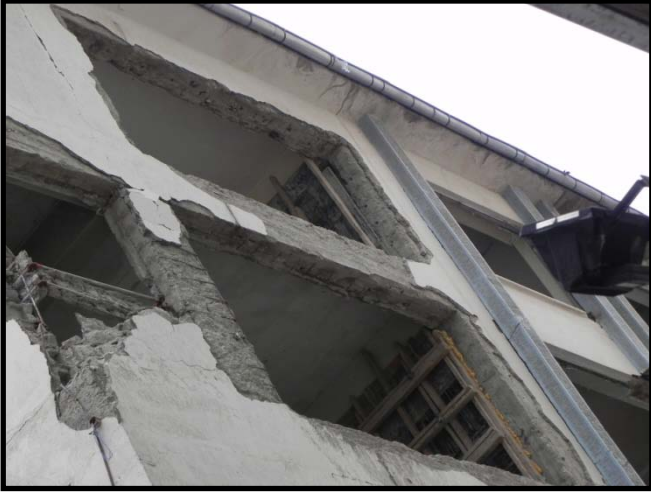
Fotoğraf/Picture 47 – SGK Binasının Kolon ve Kirişleri / Beams and Columns of the SGK Building
