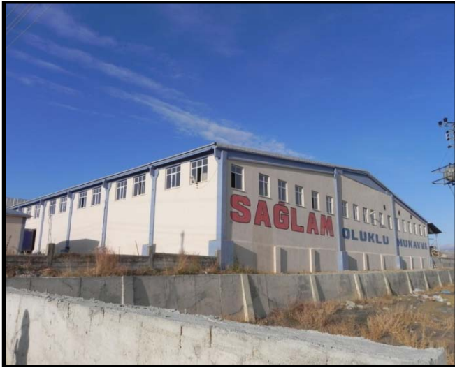
Fotoğraf/Picture 75 – OSB’de Hasarsız Betonarme Prefabrik Sanayi Yapısı / A Damage Free Building
