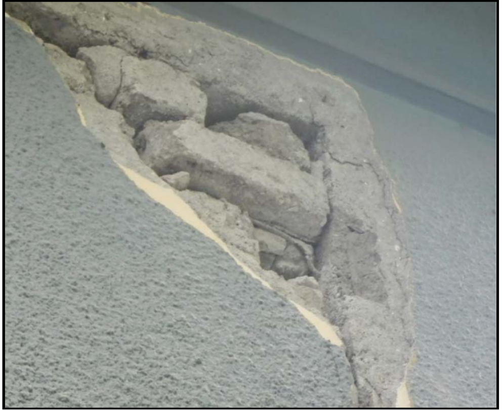
Fotoğraf/Picture 31 – Duvar Malzemesi ve Örgü Tekniği (Beton Blok ve Donatılı Duvar Örgüsü) / Wall Material and the Construction Method (Concrete Blocks and Reinforced Masonry Technique)
