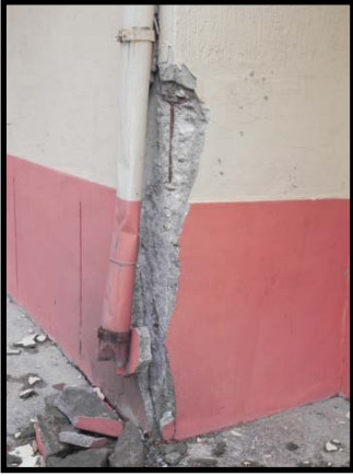
Fotoğraf/Picture 53 – s=35\text{cm} Etriye Aralığı ve Betonda Segregasyon / s=35\text{cm} Hoop Spacing and Heavy Segregation in Concrete
