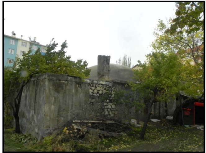
Fotoğraf/Picture 37 – Hammam Genel Görünüş / General View of Hammam
