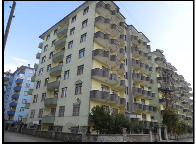
Fotoğraf/Picture 48 – Şehir Merkezinde Minimal Hasarlı Bina, (yaklaşık c_x/c_y : 30x45cm; aks açıklığı 4.00 – 5.00m) / Building with Minor Damage at City Center (approx. c_x/c_y : 30x45cm; span lengths 4.00 to 5.00 m)
