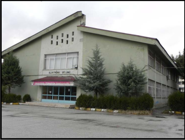
Fotoğraf/Picture 23- Elektronik Binası Genel Görünüş / General View of Electronic Education Building
