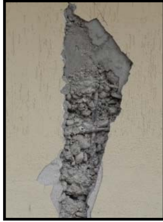
Fotoğraf/Picture 53 – s=35\text{cm} Etriye Aralığı ve Betonda Segregasyon / s=35\text{cm} Hoop Spacing and Heavy Segregation in Concrete
