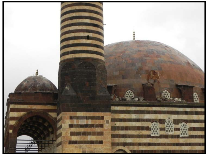
Fotoğraf/Picture 10 –Yıkılan Minarenin Ana Kubbeye ve Hafifletme Kemerlerine Verdiği Hasar / The Damage on the Main Dome and the Surrounding Semi-Arches
