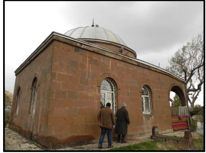
Fotoğraf/Picture 2- Şeyh Abdurrahman Gazi Camii ve Türbesi, Beden Duvarları ve Kurşun Kubbesi / Sheikh Abdurrahman Mosque Side Walls
