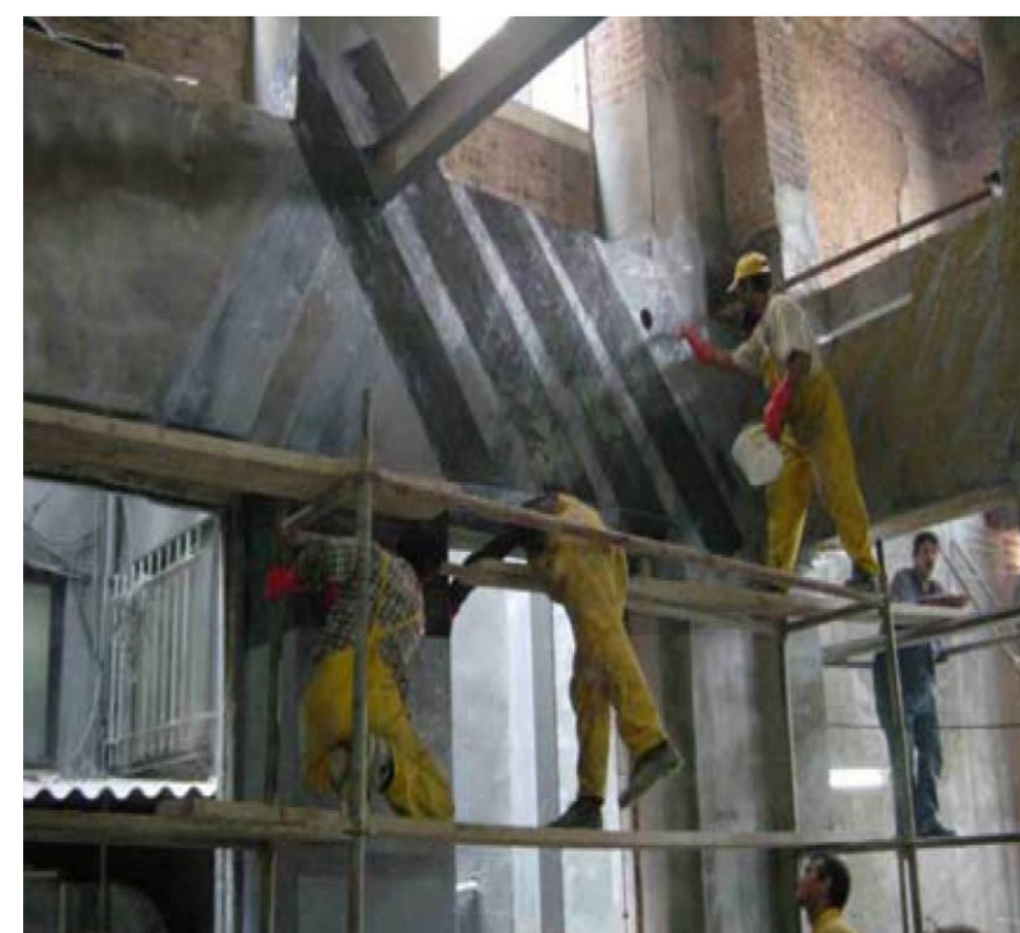
Şekil 10. Duvarların çelik çaprazlaeula güçlendirilmesi
