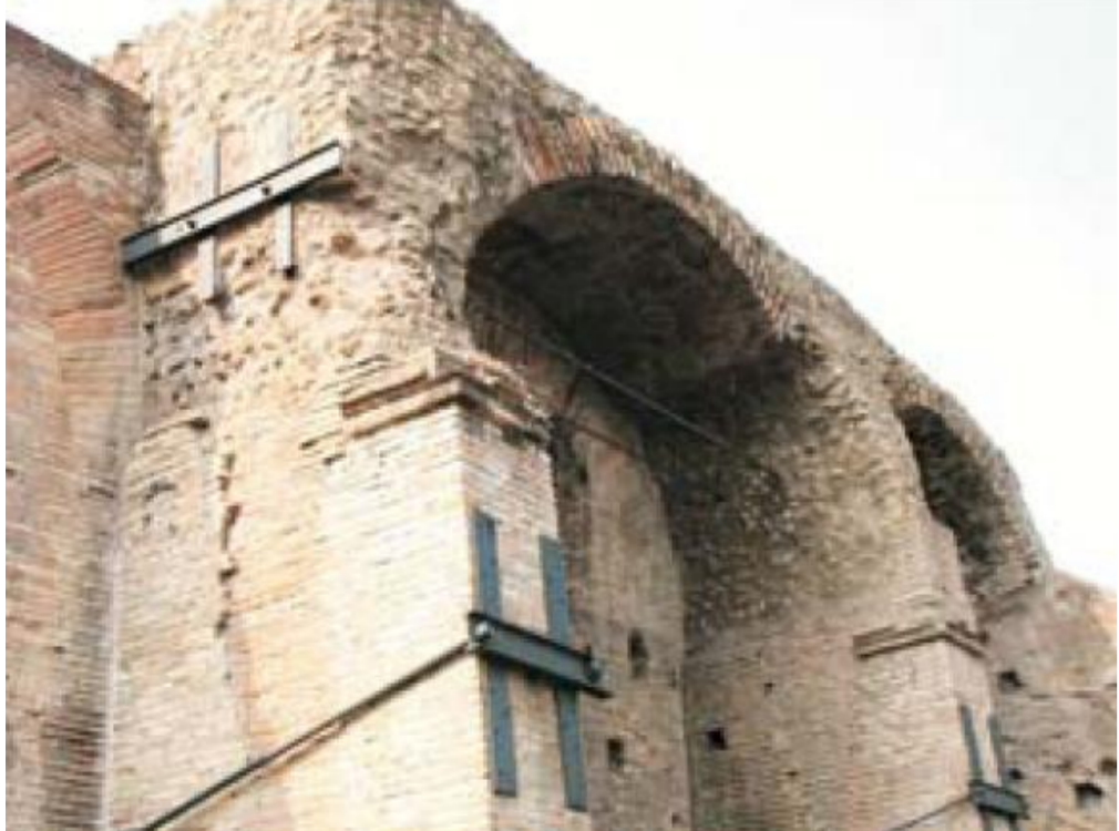
Şekil 7. Tonzolada gergi düzenlemesi
