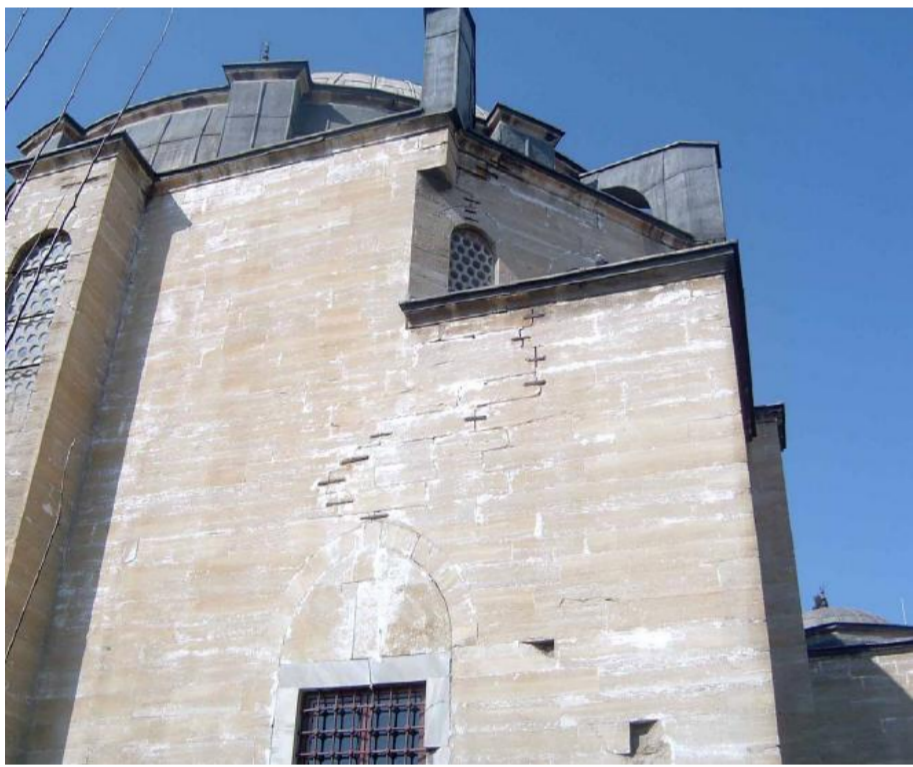
Şekil 3. Düşey çatlakların dikışı Şekil 4. Yığma duvarlarda çimento enjeksiyonu
